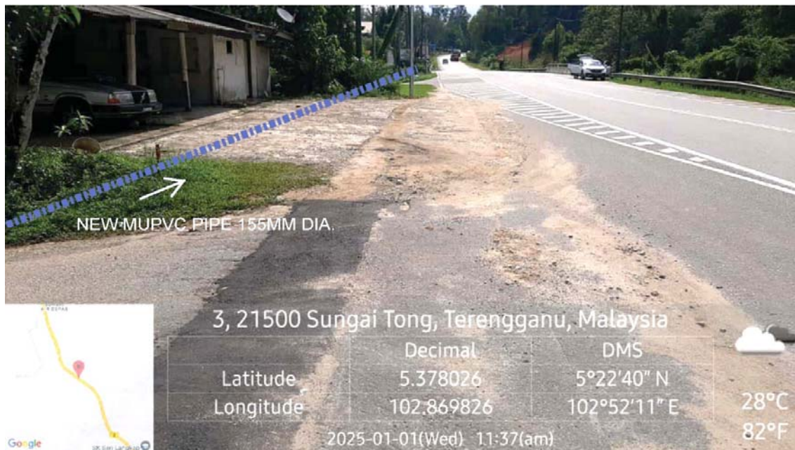
GAMBAR 2 : Kawasan cadangan laluan paip baru pada bahu jalan.
