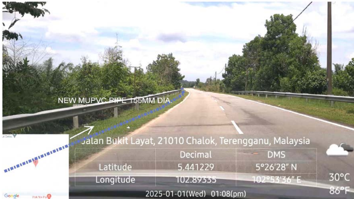
GAMBAR 3 : Kawasan cadangan laluan paip baru pada laluan bahu jalan.
