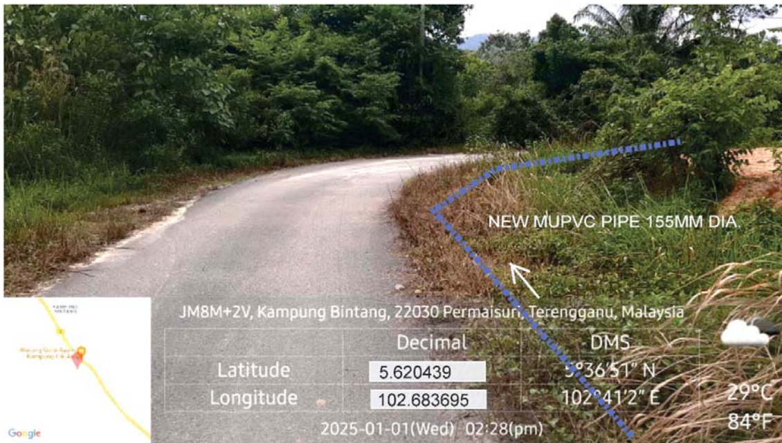
GAMBAR 6 : Kawasan cadangan laluan paip baru pada laluan bahu jalan.
