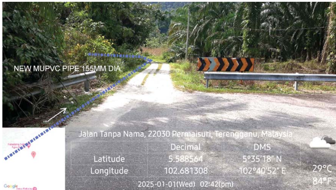
GAMBAR 3 : Kawasan cadangan laluan paip baru pada laluan bahu jalan.
