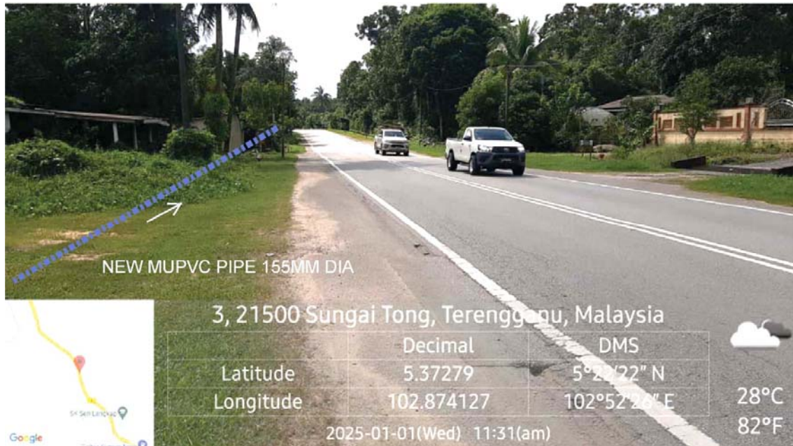
GAMBAR 5 : Kawasan cadangan laluan paip baru pada bahu jalan.
