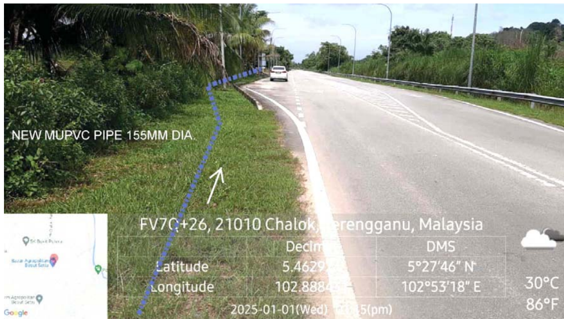
GAMBAR 8 : Kawasan cadangan laluan paip baru pada laluan bahu jalan.
