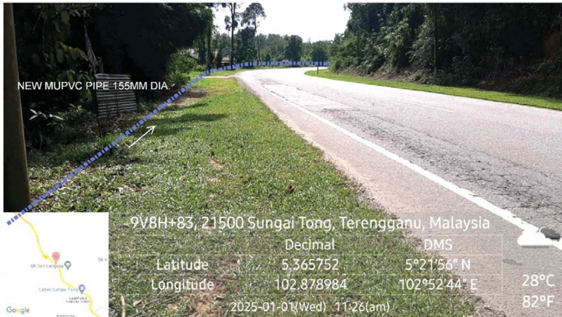
GAMBAR 7 : Kawasan cadangan laluan paip baru pada bahu jalan.
