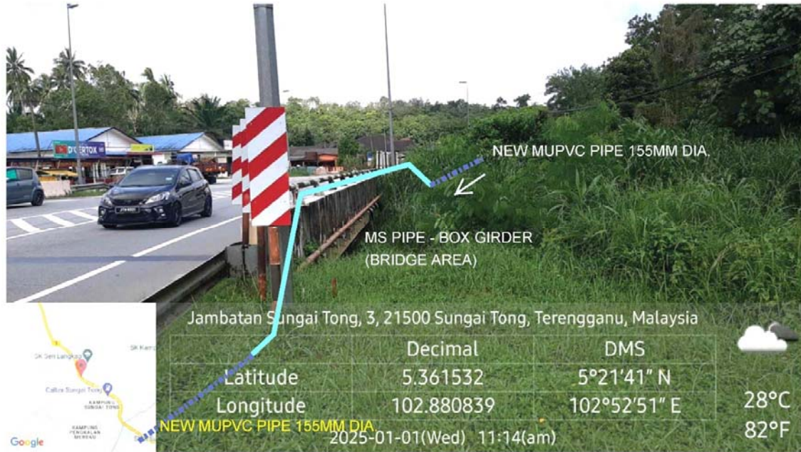
GAMBAR 9 : Kawasan cadangan laluan paip baru pada bahu jalan.
