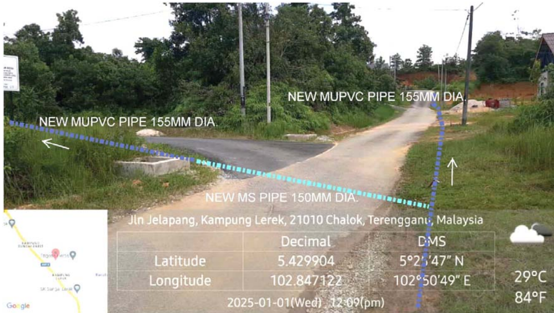
GAMBAR 5 : Kawasan cadangan laluan paip baru pada laluan bahu jalan.
