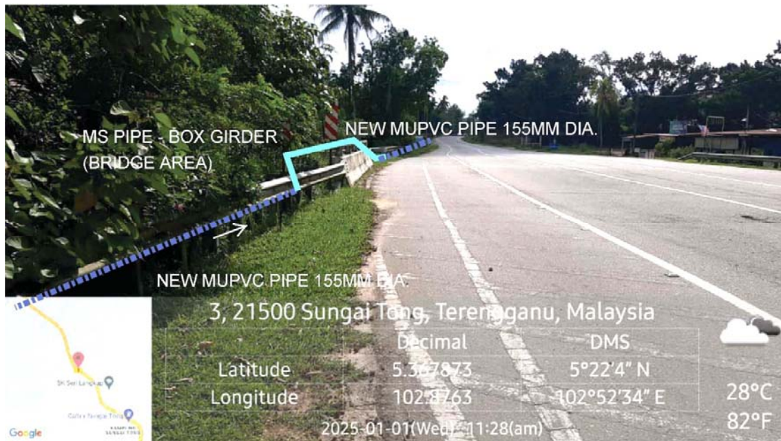
GAMBAR 6 : Kawasan cadangan laluan paip baru pada bahu jalan.
