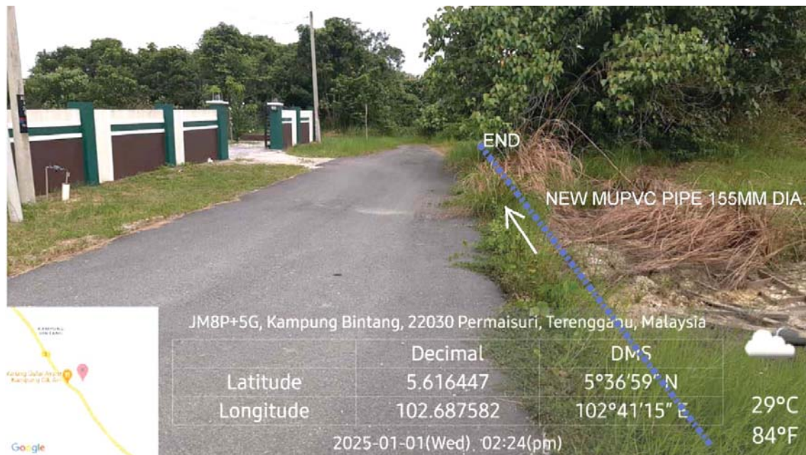
GAMBAR 2 : Kawasan cadangan laluan paip baru pada laluan bahu jalan.
