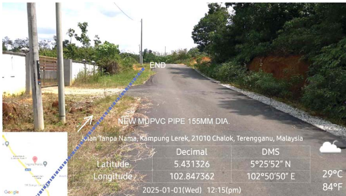
GAMBAR 7 : Kawasan cadangan laluan paip baru pada laluan bahu jalan.
