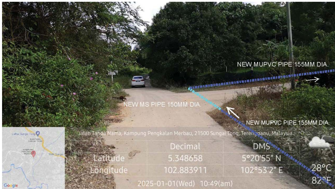
GAMBAR 4 : Kawasan cadangan laluan paip baru pada laluan bahu jalan.
