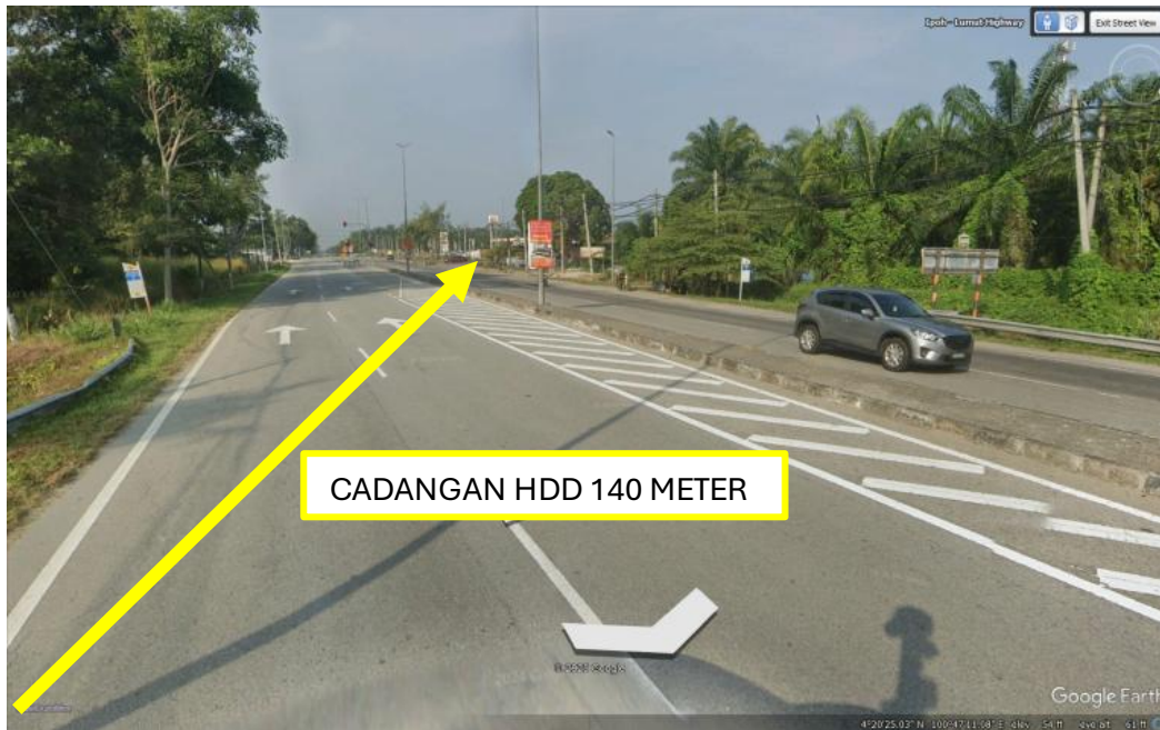
GAMBAR 1 : KAWASAN KERJA MELIBATKAN HORIZONTAL DIRECTIONAL DRILLING (HDD)
