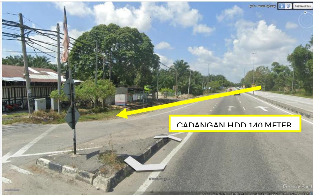
GAMBAR 2 : KAWASAN KERJA MELIBATKAN HORIZONTAL DIRECTIONAL DRILLING (HDD)
