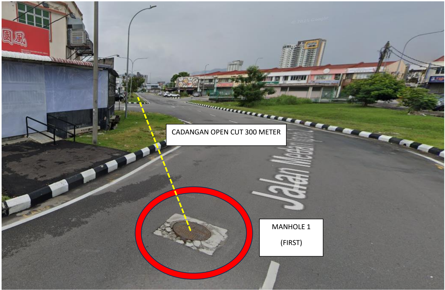
Gambar 2: Kawasan Kerja Melibatkan Pemotongan Jalan (Open Cut)
