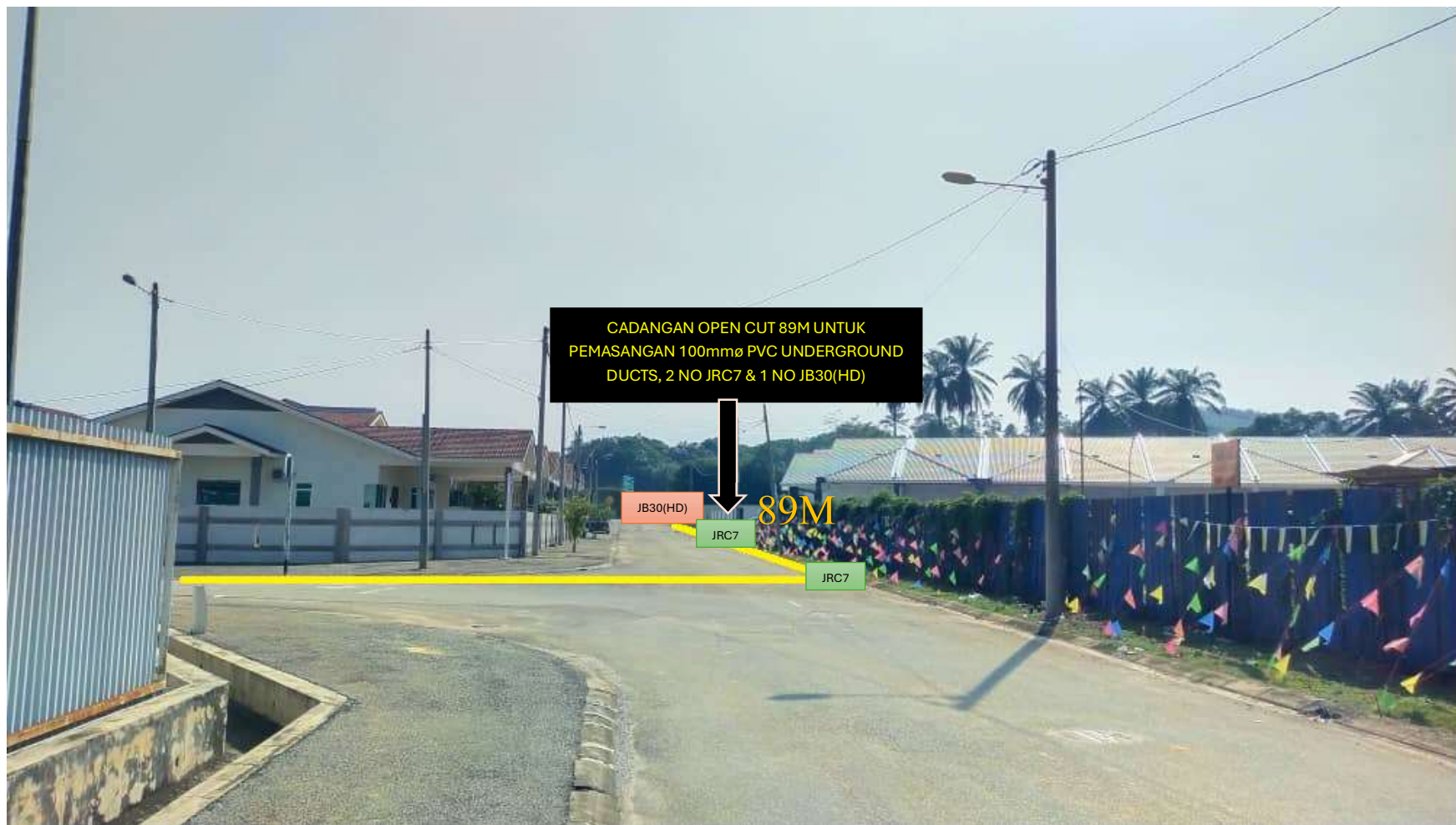
Gambar 3 : KAWASAN KERJA MELIBATKAN PEMOTONGAN JALAN (OPEN CUT) 89M UNTUK PEMASANGAN 100mmø PVC UNDERGROUND DUCTS, 2 NO JRC7 & 1 NO JB30(HD)
