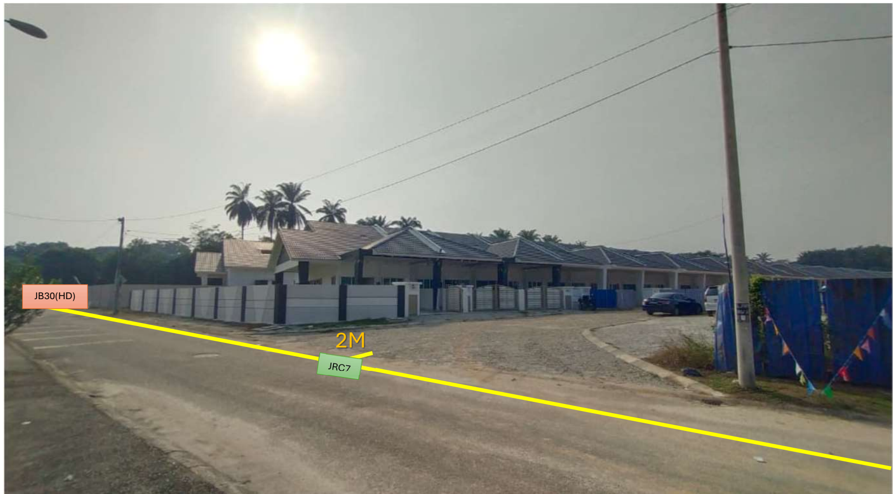
Gambar 4 : KAWASAN KERJA MELIBATKAN PEMOTONGAN JALAN (OPEN CUT) 2M UNTUK PEMASANGAN 100mmø PVC UNDERGROUND DUCTS
