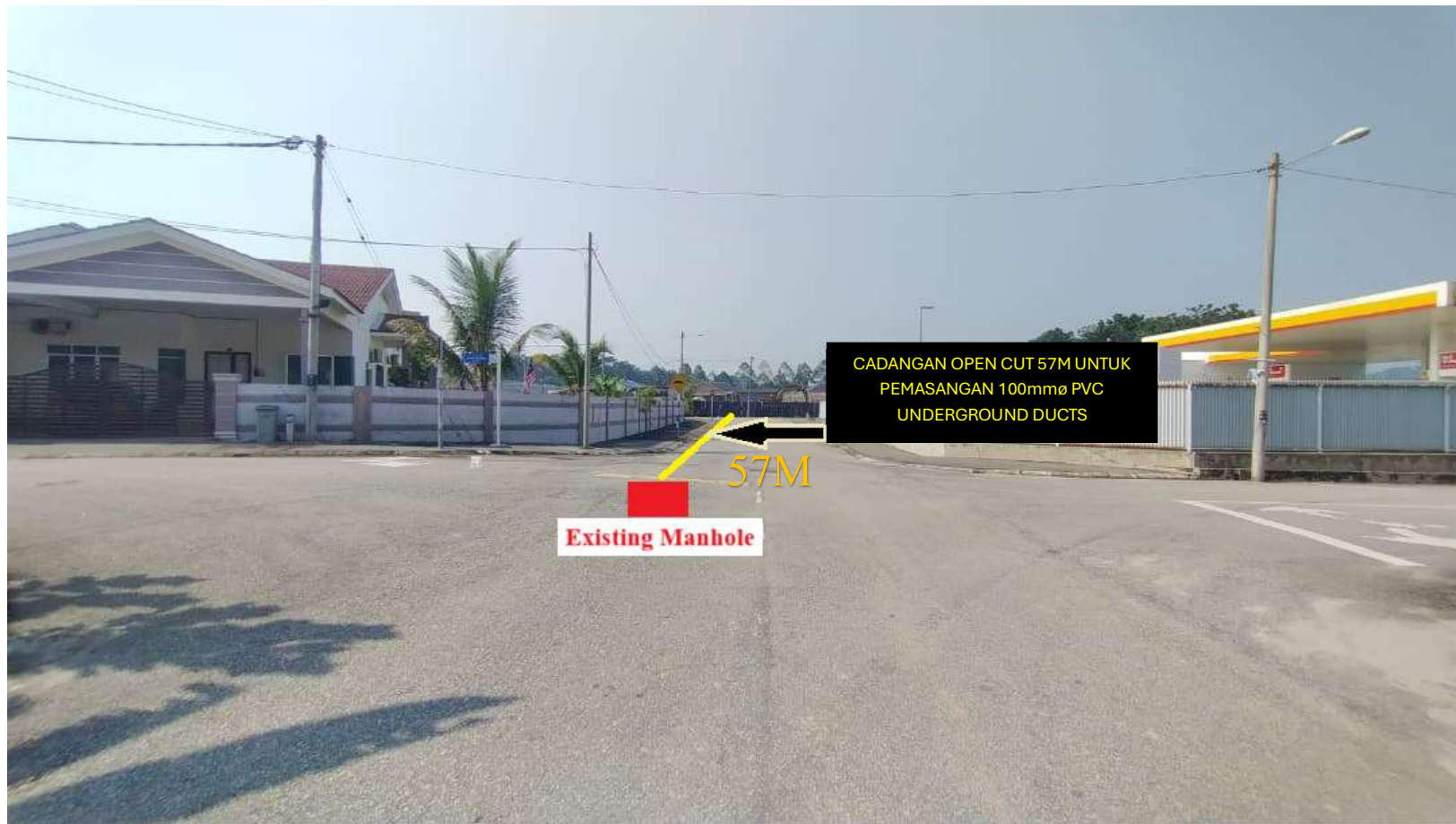
Gambar 2 : KAWASAN KERJA MELIBATKAN PEMOTONGAN JALAN (OPEN CUT) 57M UNTUK PEMASANGAN 100mmø PVC UNDERGROUND DUCTS
