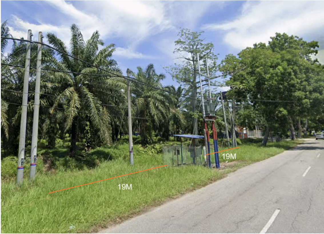
CADANGAN KOREKAN OPEN CUT DI JALAN SIAKAP.
