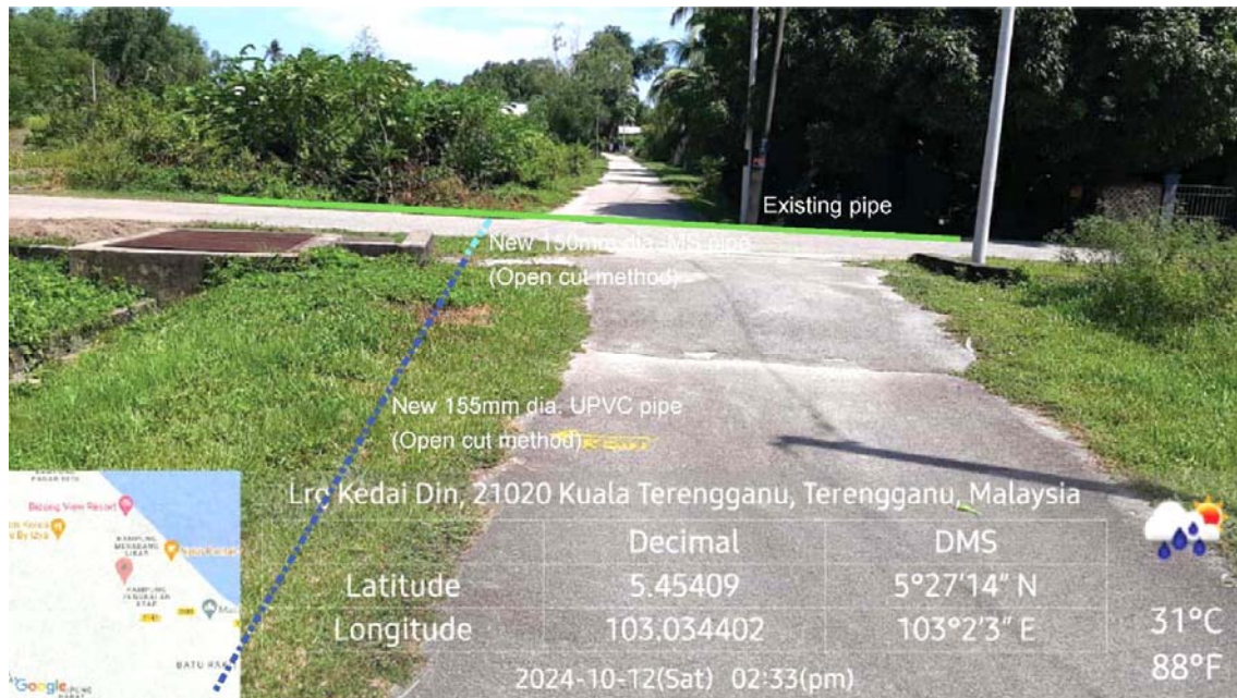
GAMBAR 7 : Kawasan cadangan laluan paip baru dan sambungan ke paip sedia ada.
