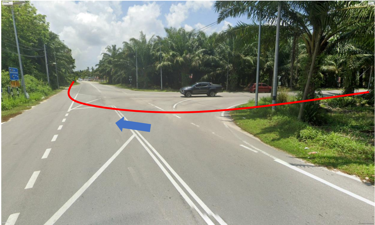
GAMBAR 3: KAWASAN KERJA MELIBATKAN 'HORIZONTAL DIRECTIONAL DRILLING'
