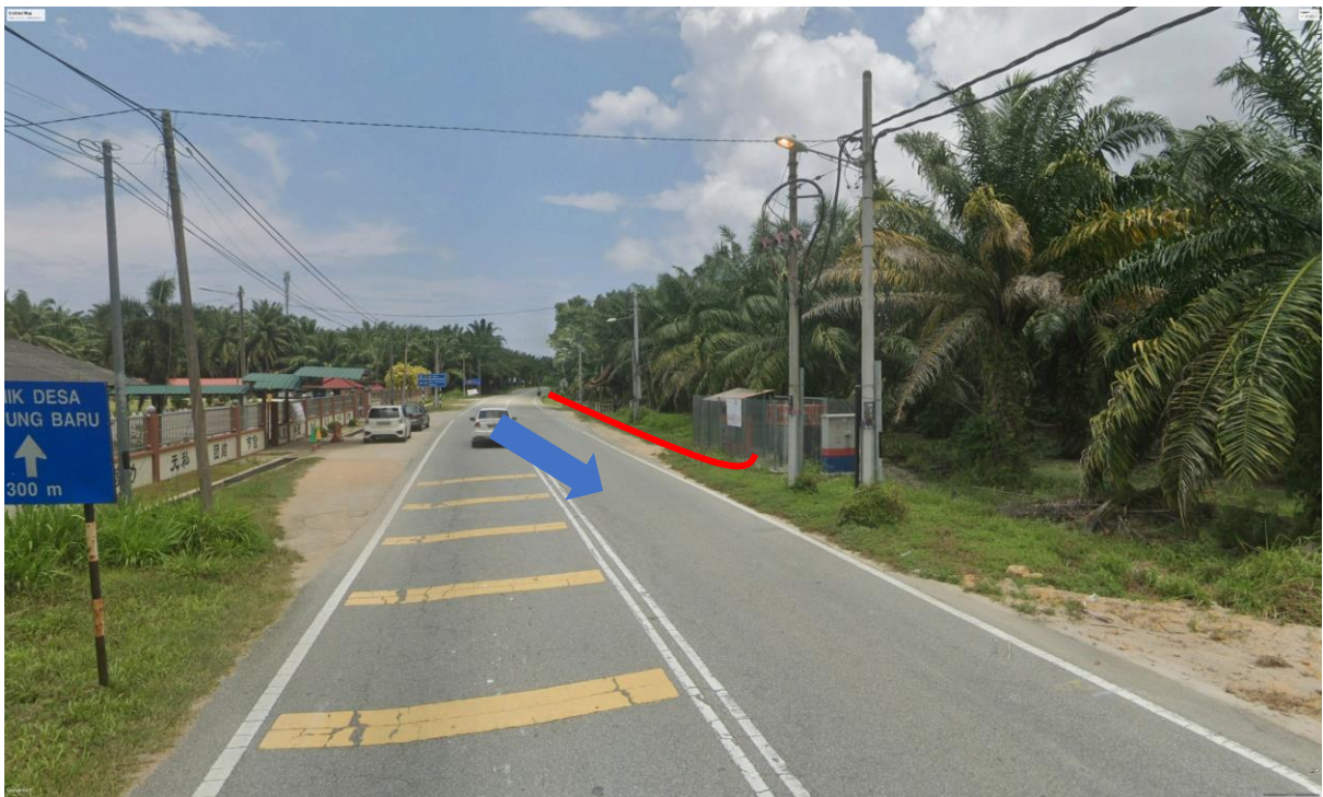
GAMBAR 4: KAWASAN KERJA MELIBATKAN 'HORIZONTAL DIRECTIONAL DRILLING'
