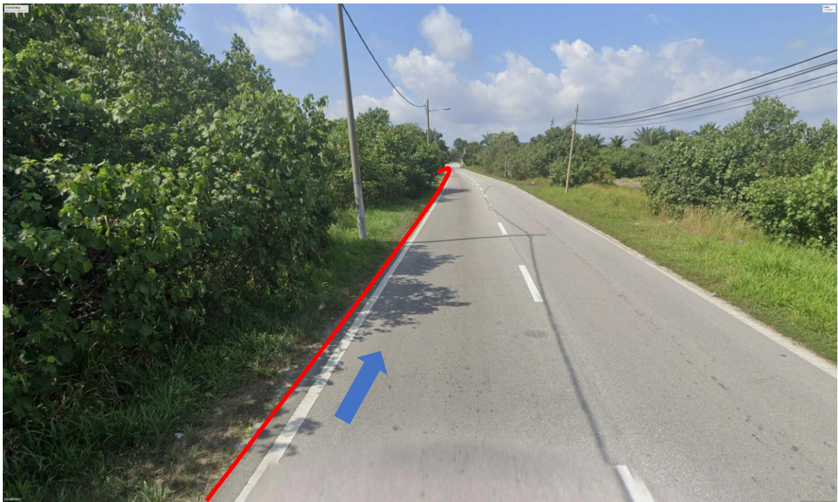
GAMBAR 2: KAWASAN KERJA MELIBATKAN 'HORIZONTAL DIRECTIONAL DRILLING'
