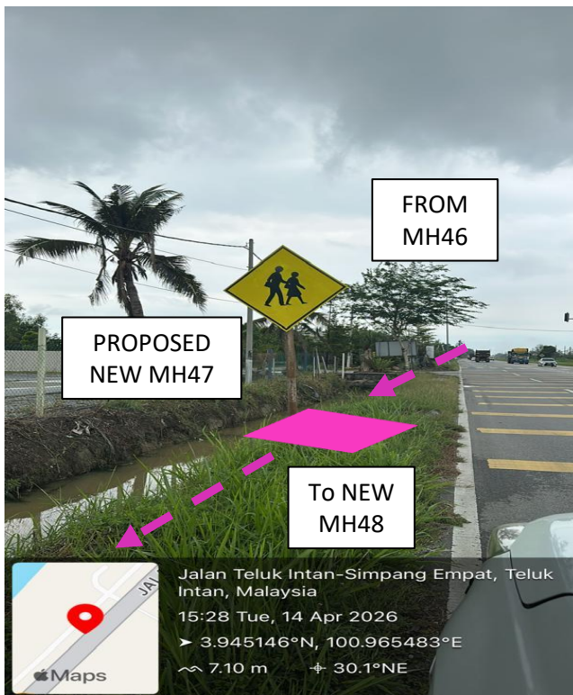
PROP. MH47 JALAN TELUK INTAN – SIMPANG EMPAT
