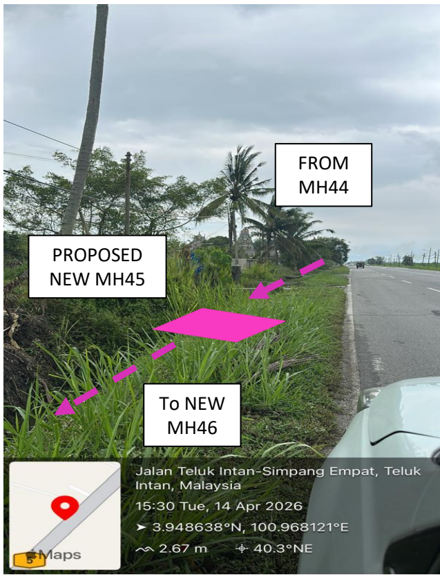
PROP. MH45 JALAN TELUK INTAN – SIMPANG EMPAT
