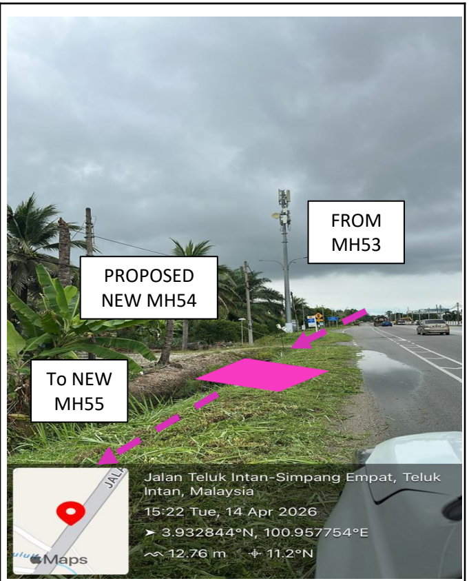
PROP. MH54 JALAN TELUK INTAN – SIMPANG EMPAT
