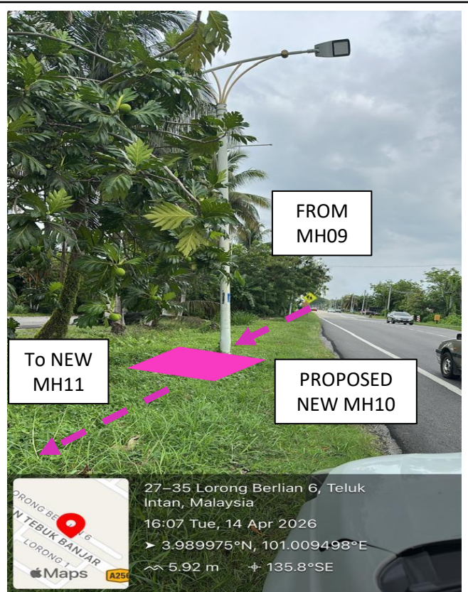
PROP. MH10 JALAN TEBUK BANJAR
