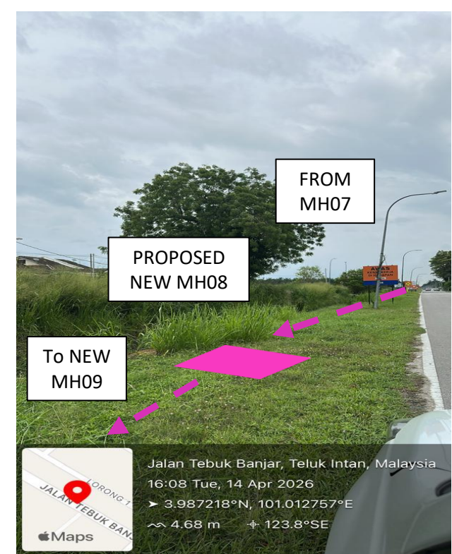
PROP. MH08 JALAN TEBUK BANJAR
