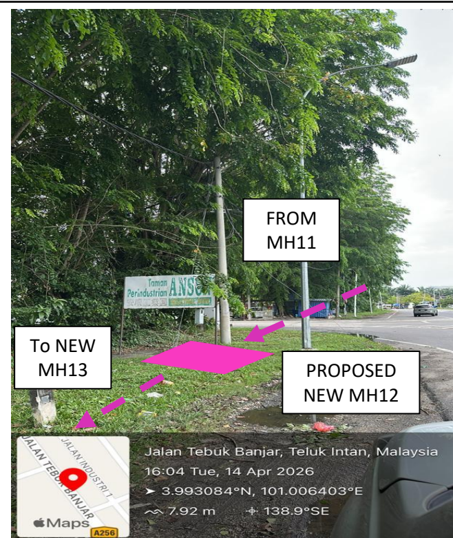
PROP. MH12 JALAN TEBUK BANJAR
