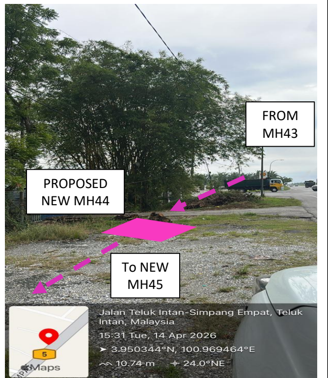
PROP. MH44 JALAN TELUK INTAN – SIMPANG EMPAT
