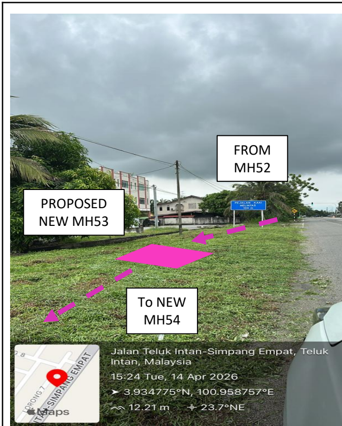
PROP. MH53 JALAN TELUK INTAN – SIMPANG EMPAT
