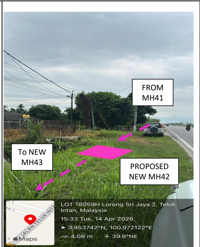
PROP. MH42 JALAN TELUK INTAN – SIMPANG EMPAT
