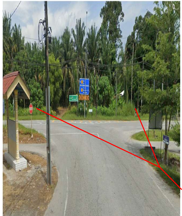
JALAN TELUK INTAN - BIDOR (HDD)
