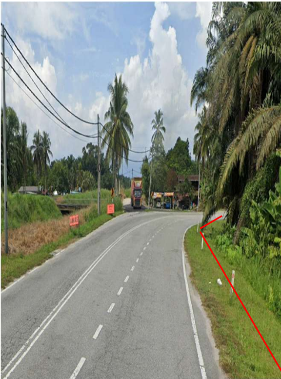
JALAN LANGKAP-AYER HITAM (A129) (TANAM TIANG)
