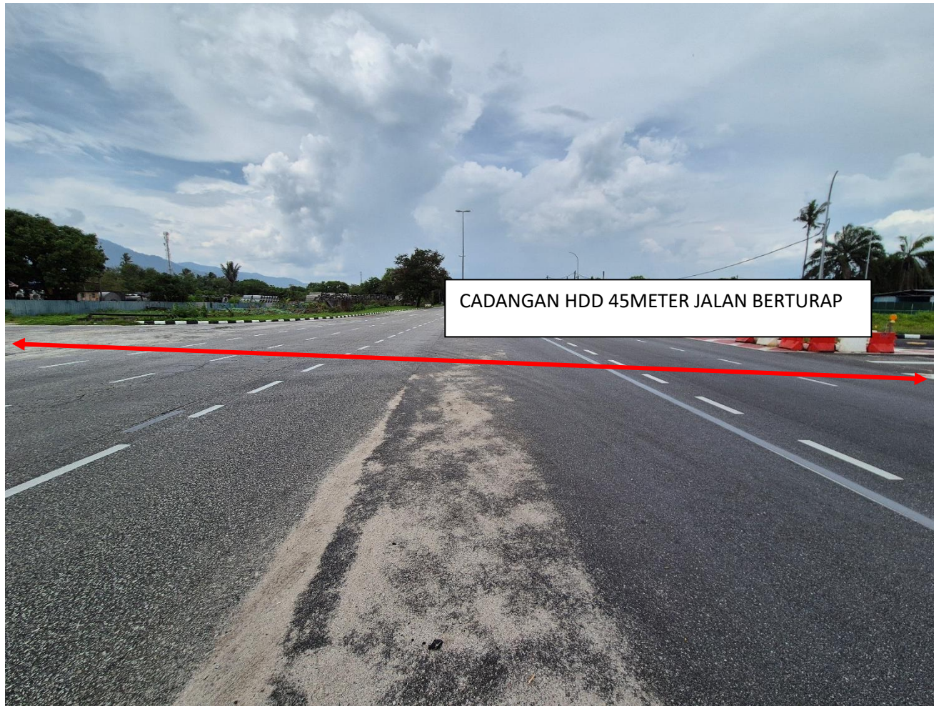
GAMBAR 2 : KAWASAN KERJA MELIBATKAN KERJA HDD
