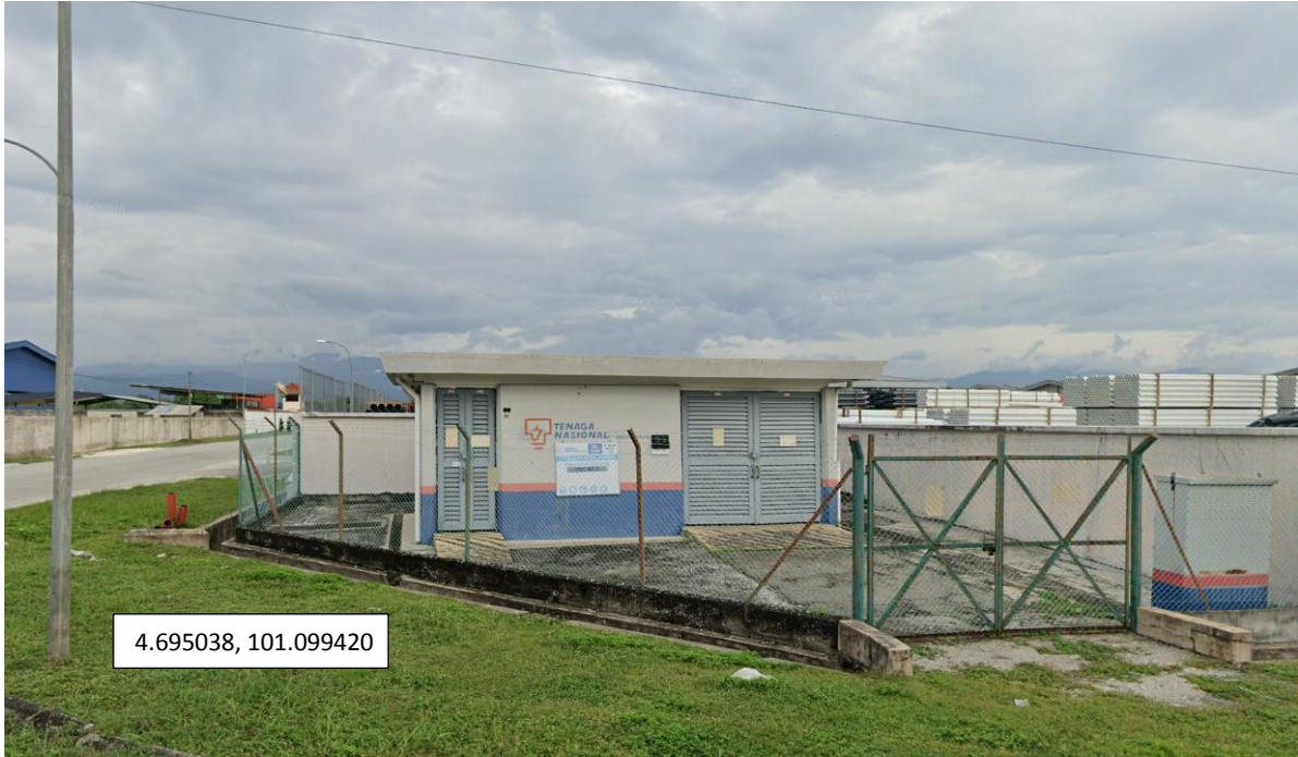
GAMBAR 1 : PENCAWANG SEDIADA PISC NO . 3 (JALAN CHEPOR 11/9)
