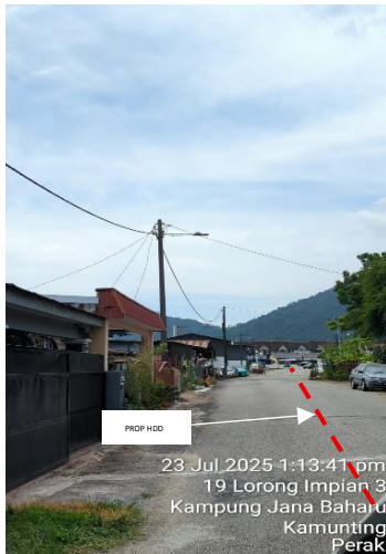
PROP HDD AT JALAN TAK BERNAMA
