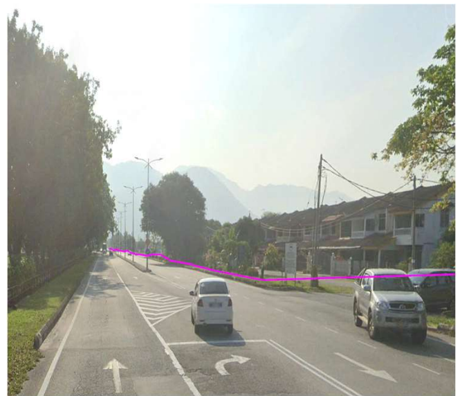
JALAN BATU SINAR (HDD)
