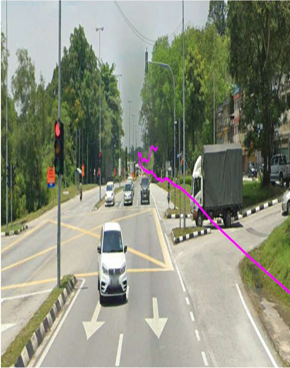
JALAN IPOH - KAMPAR (HDD)
