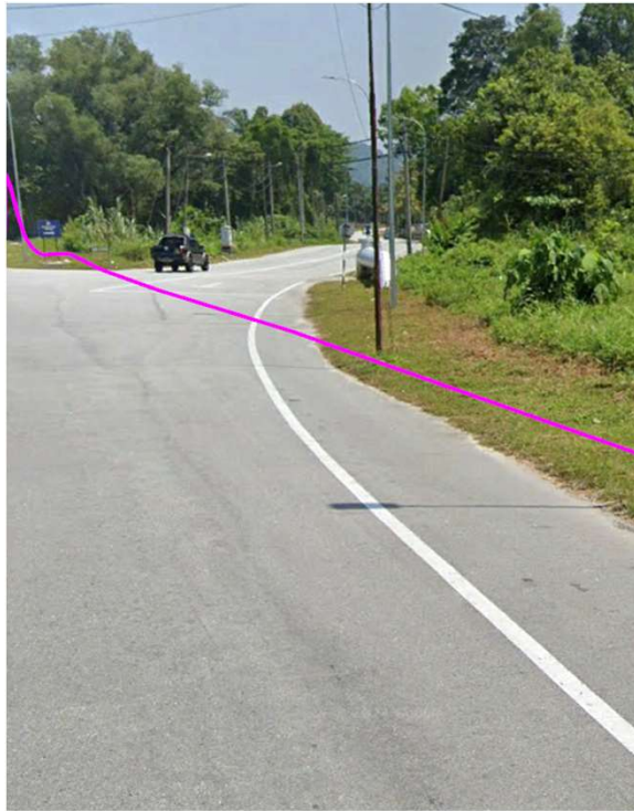
JALAN IPOH - KAMPAR (HDD)
