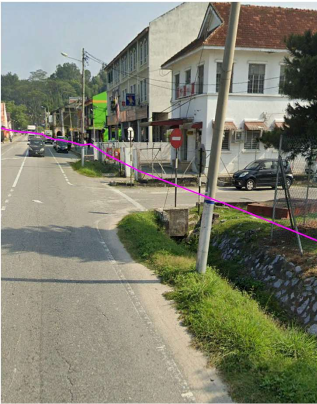
JALAN IPOH - KAMPAR (HDD)
