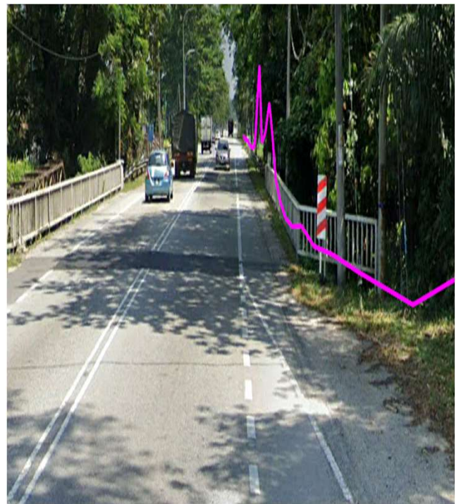
JAMBATAN SUNGAI KAMPAR (HDD)
