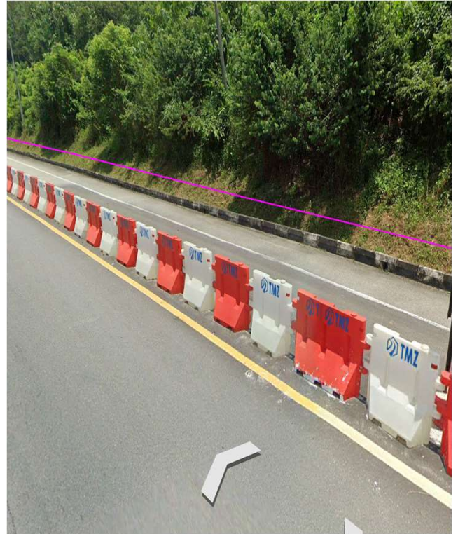
JALAN IPOH - KAMPAR (TANAM TIANG)
