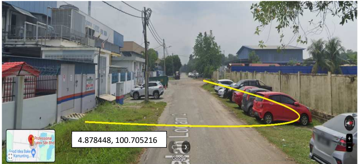
1) LOKASI MULA KERJA JALAN LOGAM
