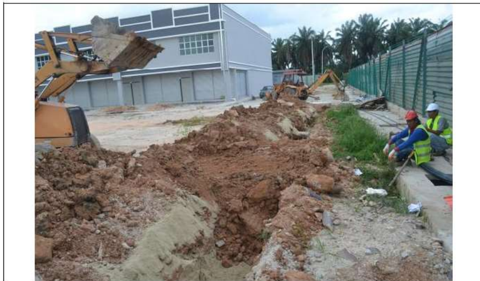
1.4.3 Peparit kabel ditutup dengan pasir baru dan dimampatkan dengan compactor .
