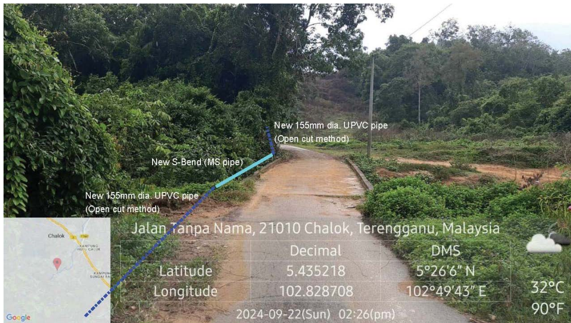
GAMBAR 2 : Kawasan cadangan laluan paip baru pada laluan tepi jalan.
