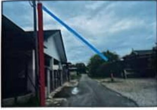
CADANGAN MERENTANG KABEL DI ATAS CADANGAN TIANG BARU (TUKAR TIANG)
