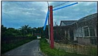
CADANGAN MERENTANG KABEL DI ATAS CADANGAN TIANG BARU (TUKAR TIANG)
