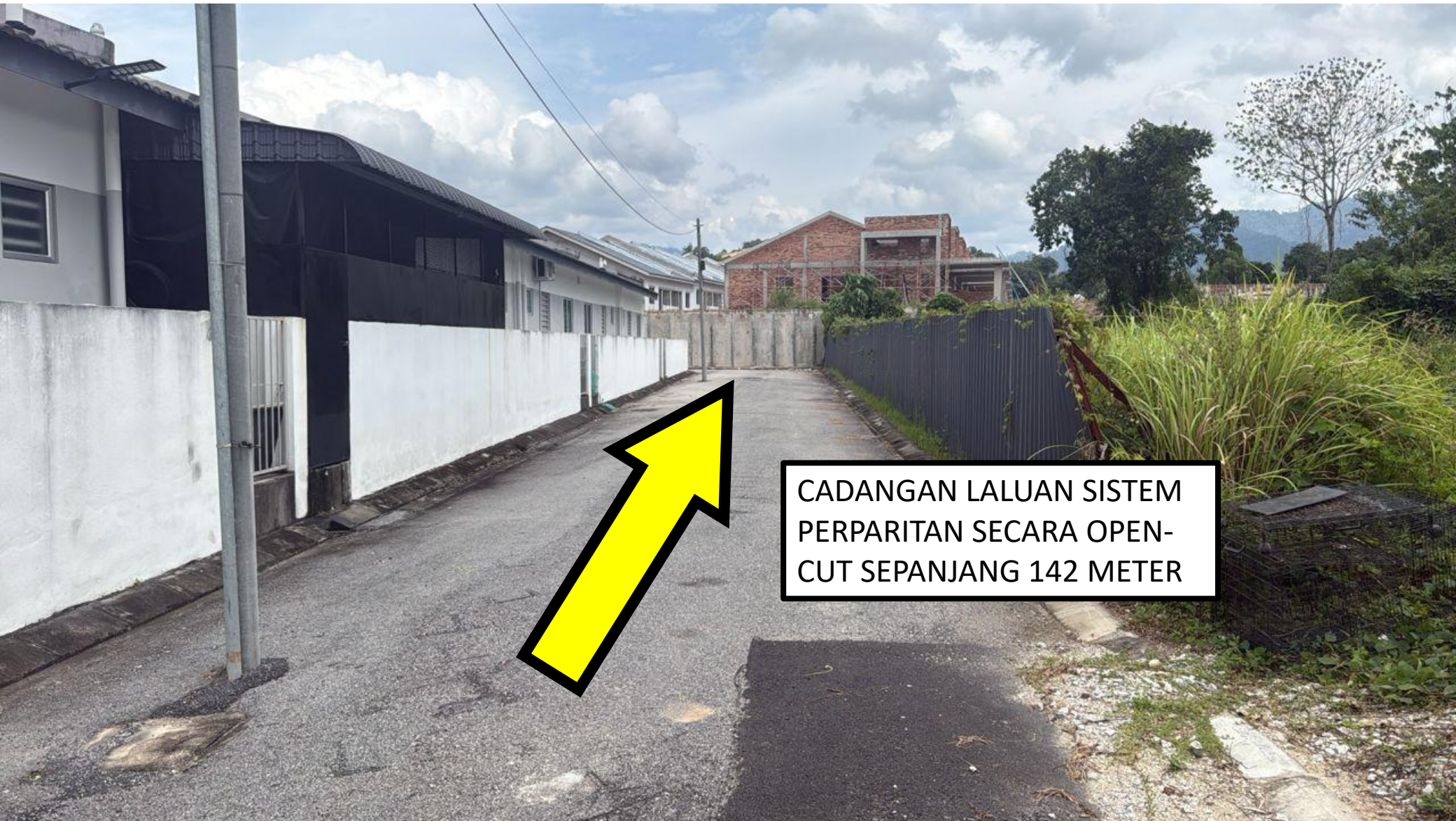
GAMBAR 3: KAWASAN KERJA MALIBATKAN KOREKAN JALAN BERTURAP
