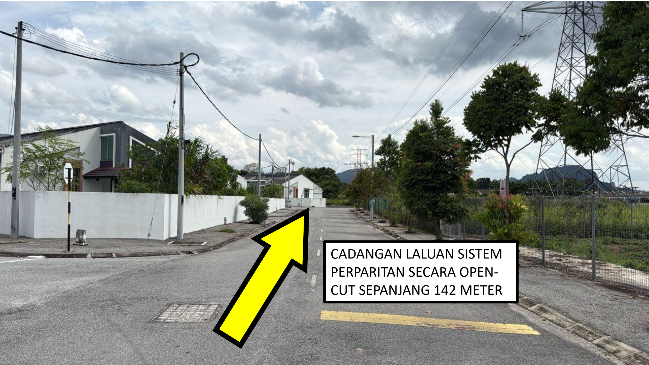
GAMBAR 1: KAWASAN KERJA MALIBATKAN KOREKAN JALAN BERTURAP
