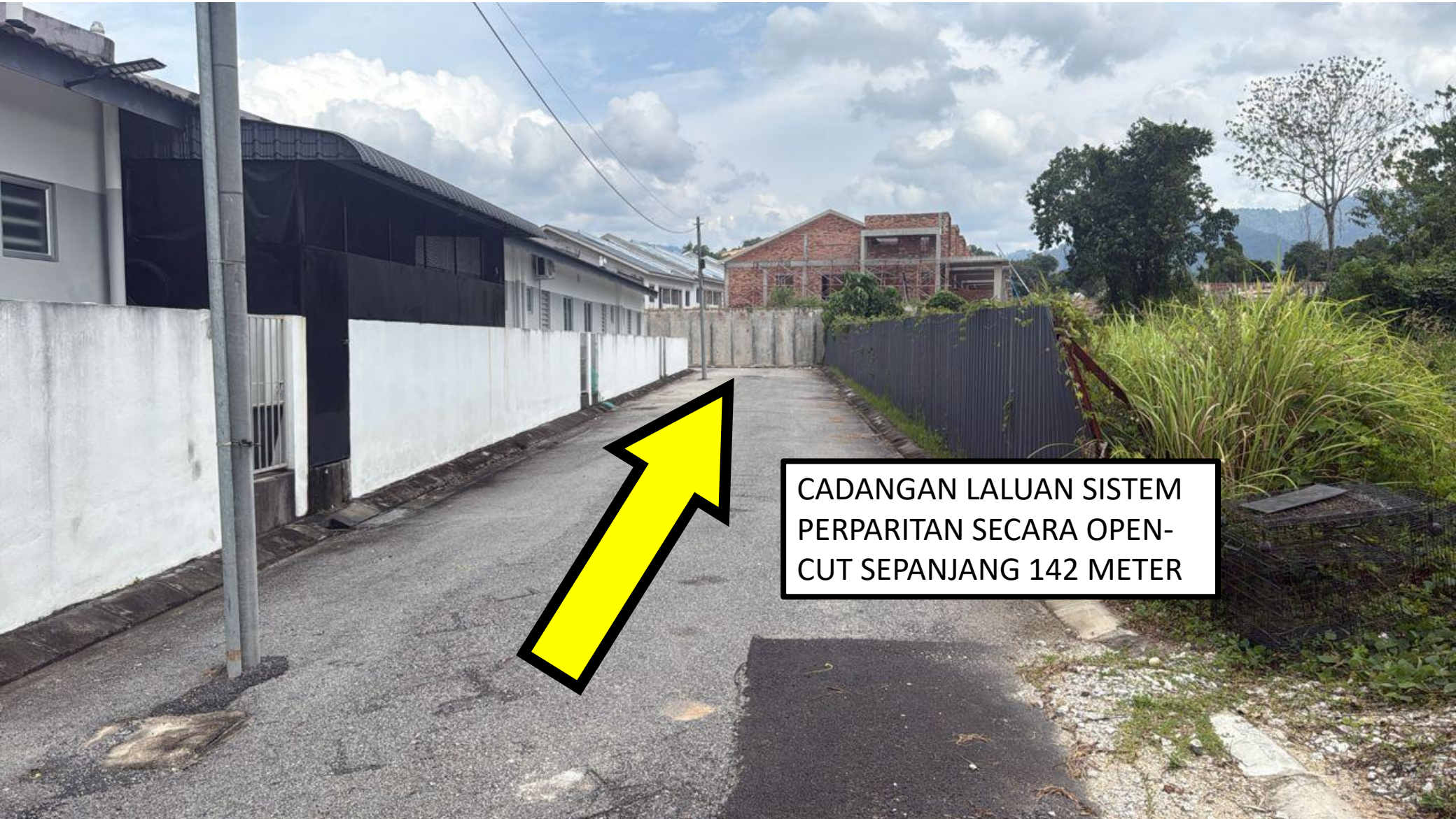
GAMBAR 3: KAWASAN KERJA MALIBATKAN KOREKAN JALAN BERTURAP
