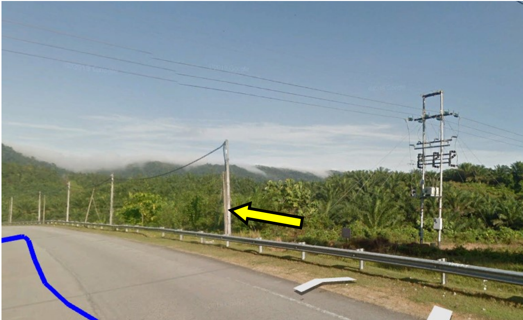
Laluan kanan jalan. Cadangan Kerja Open cut - Bawah TNB Pylon 4.581229° 103.305042°
