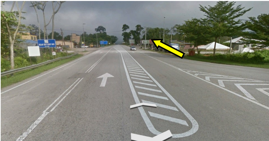
Laluan kanan jalan
