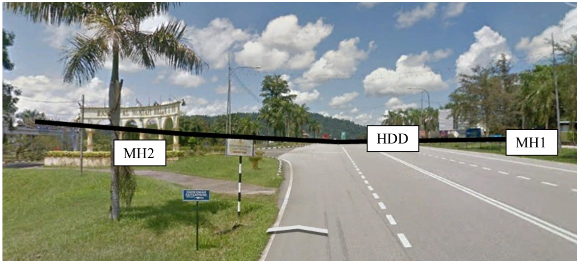
Cadangan Kerja HDD - Menyeberang jalan 4.620424° 103.215834°
