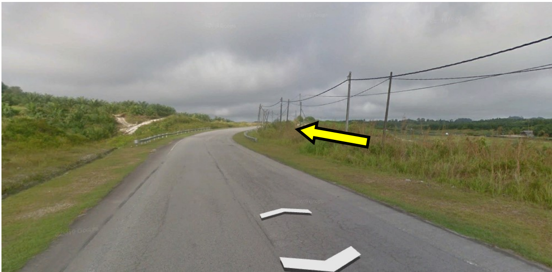
Laluan kanan jalan
