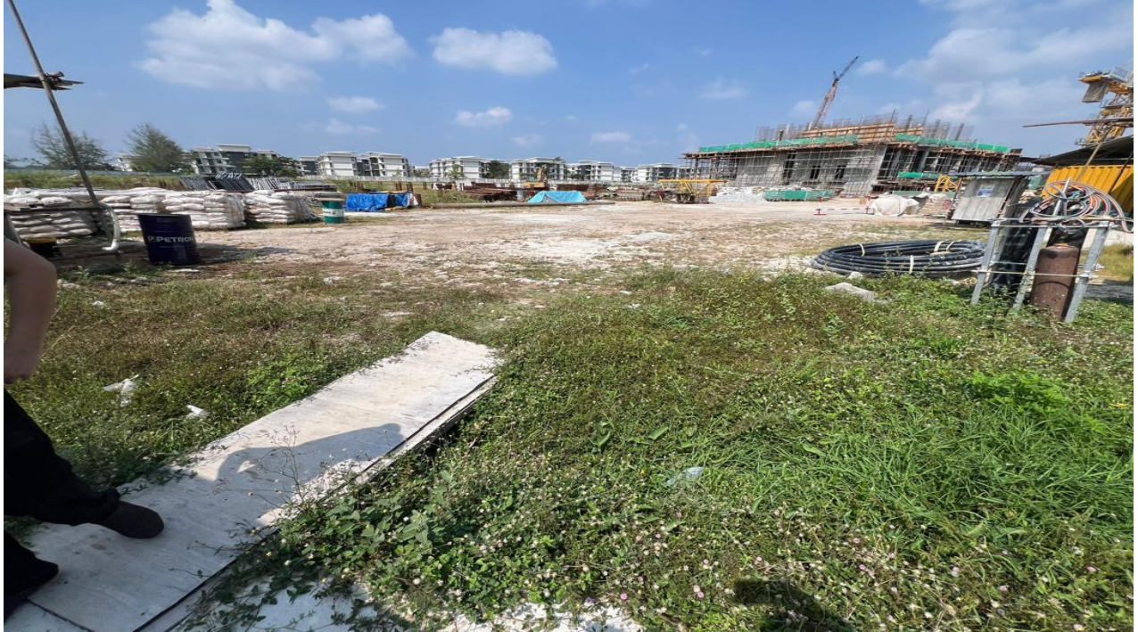
Rajah 1: Lokasi tapak pembinaan Stesen Pam Kumbahan
