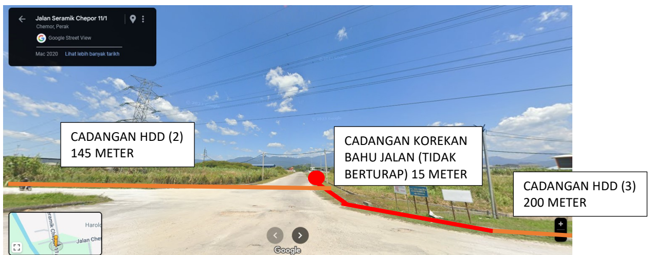
GAMBAR 6: KAWASAN KERJA MELIBATKAN 'HORIZONTAL DIRECTIONAL DRILLING' & PEMOTONGAN BAHU JALAN (TIDAK BERTURAP)
