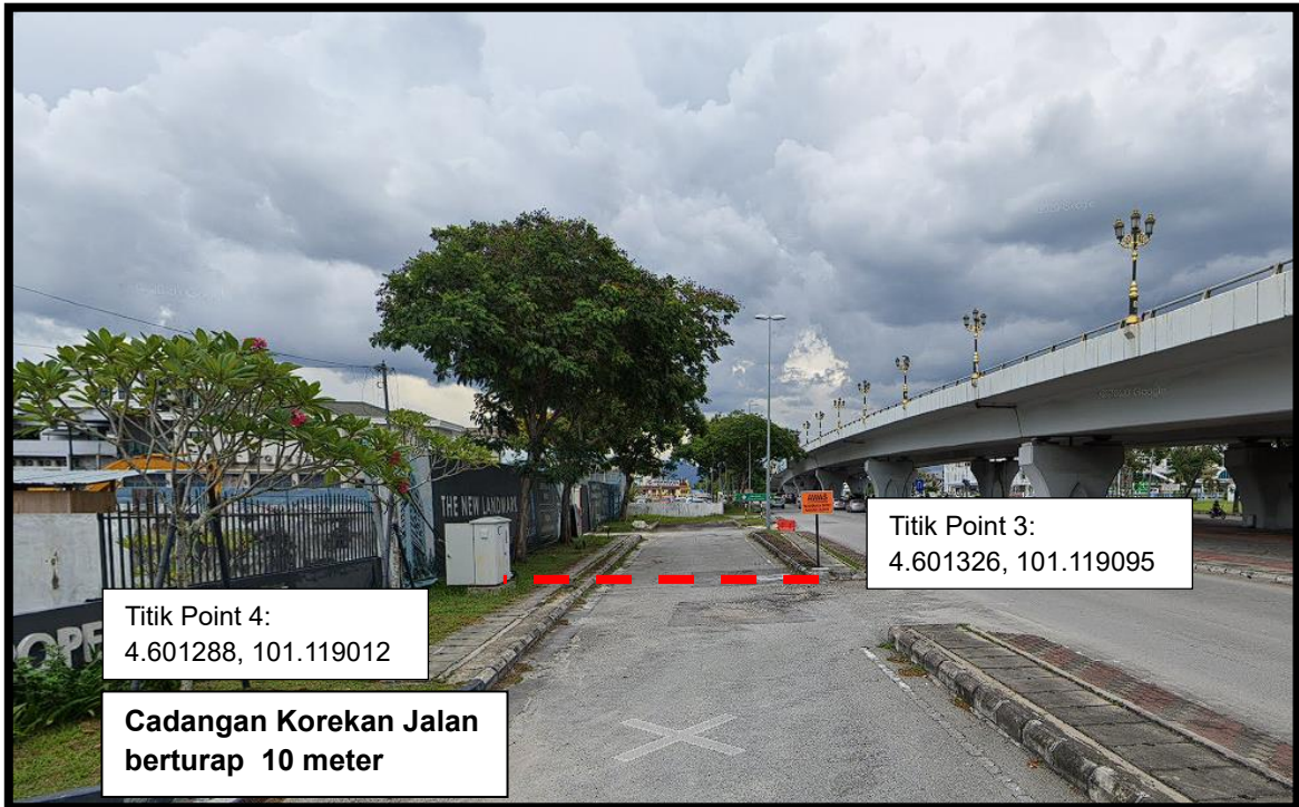
PHOTO : KAWASAN PEMASANGAN KABEL
