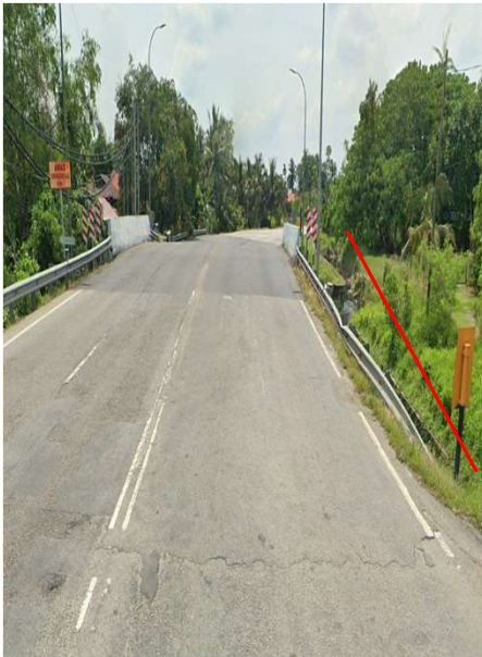
JALAN TELUK INTAN – BIDOR (HDD)
