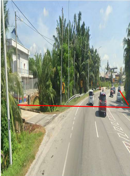
PPU TELUK INTAN JALAN TELUK INTAN – BIDOR (HDD)
