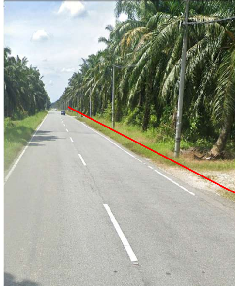
JALAN TEBUK BANJAR (HDD)
