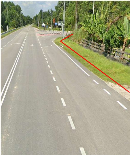
JALAN TEBUK BANJAR JALAN MISDI (HDD)
