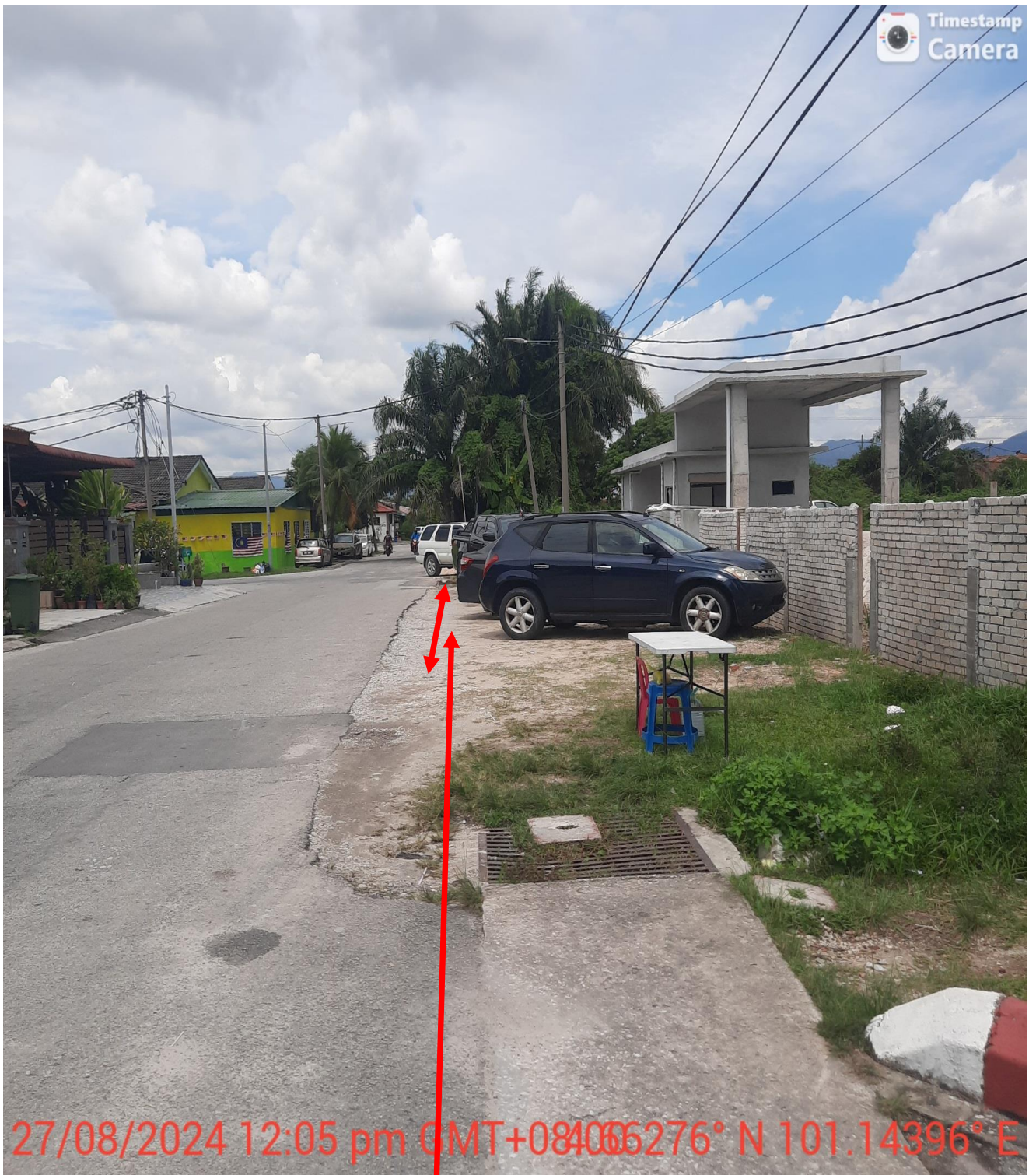
KOREKAN JALAN TIDAK BERTURAP (POTONG & SAMBUNG) JARAK - 1 METER
