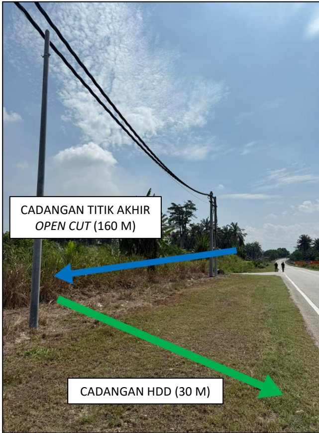
GAMBAR 7 : KAWASAN KERJA MELIBATKAN OPEN CUT DAN HORIZONTAL DIRECTIONAL DRILLING (HDD)
