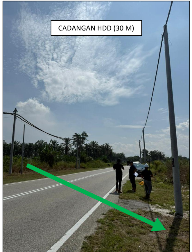
GAMBAR 8 : KAWASAN KERJA MELIBATKAN HORIZONTAL DIRECTIONAL DRILLING (HDD)
