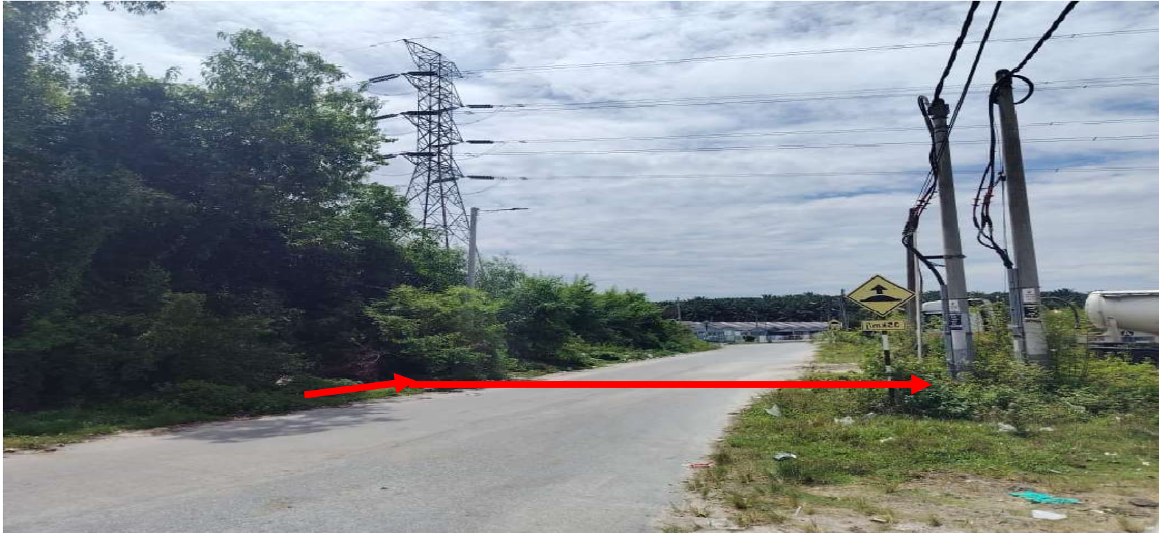
JALAN PERSIARAN PERMAI-KAEDAH OPEN CUT
