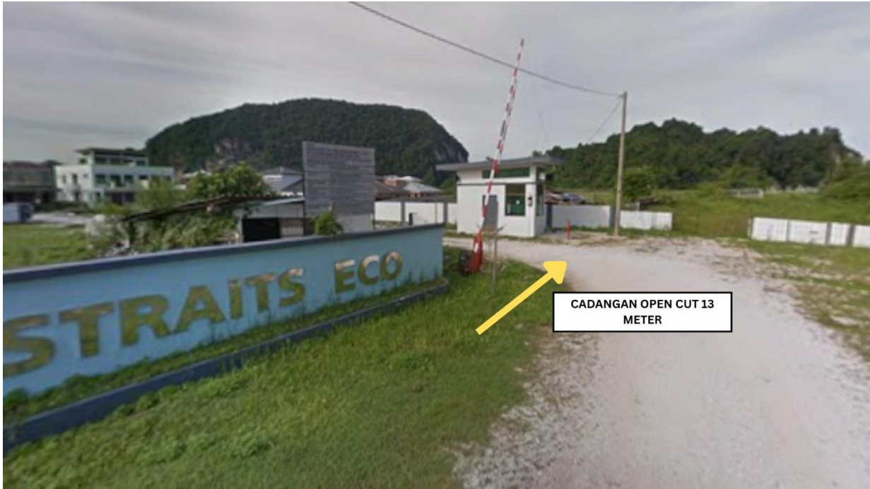
GAMBAR 2: KAWASAN KERJA MELIBATKAN PEMOTONGAN JALAN (OPEN CUT)
